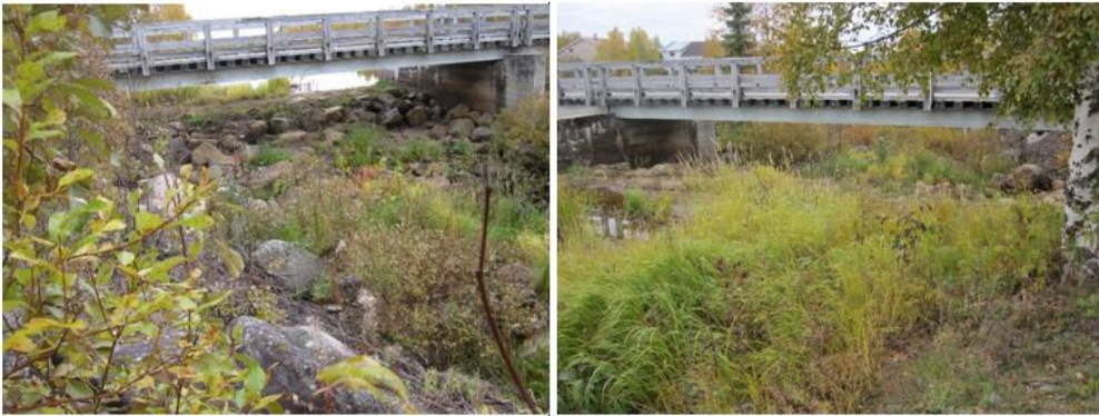
Kalatien yläpään alue säännöstelypadon alapuolelta ja yläpuolelta katsottuna (kuvat H. Alatalo)
